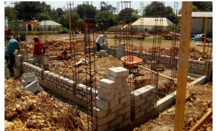
CONSTRUCCION DE 04 AULAS (01 SERV SANITARIO) EDIFICIO "A", MUROS Y COLADO DE CASTILLOS.
